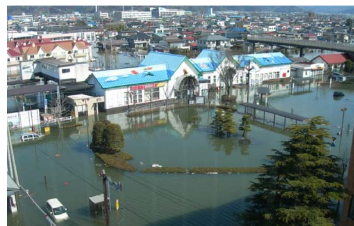
JR石巻駅前浸水状況（3月12日10:25）
