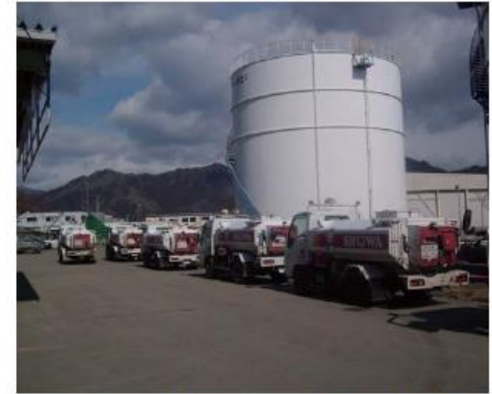
↑ 2011.3.25 岩手県釜石市:岩手県オイルターミナルにて
