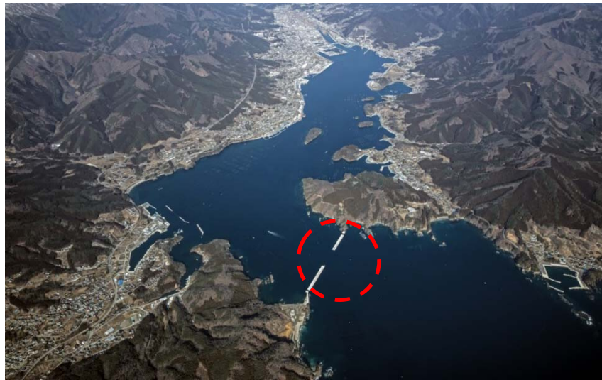
▲ 大船渡港湾口防波堤の復旧（平成28年度完成）
