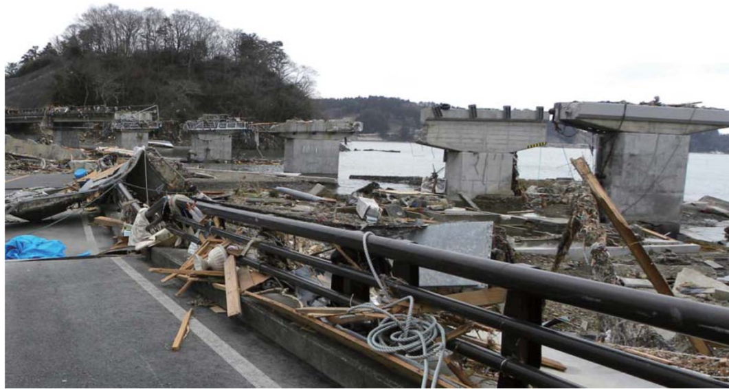
▲ 橋梁が流出した「国道45号 歌津（うたつ）大橋」（宮城県南三陸町）
