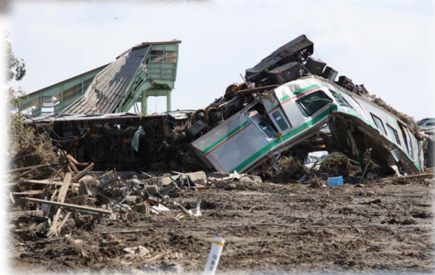
② 津波により破壊された電車 (手前) と跨線橋 (奥)
