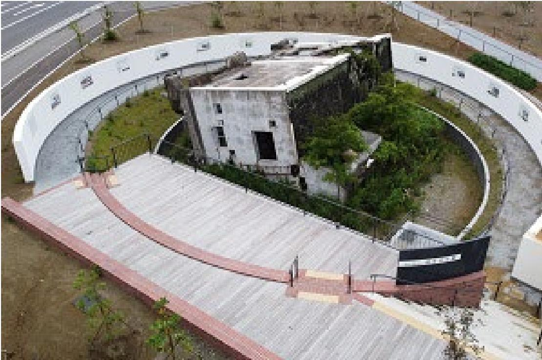
旧女川交番は、鉄筋コンクリート造2階建てで、東日本大震災における津波の引き波により、基礎部分の杭が引き抜かれ横倒しになったと考えられており、鉄筋コンクリート造の建物が津波で倒壊・転倒した事例は世界的にも珍しいものです。
